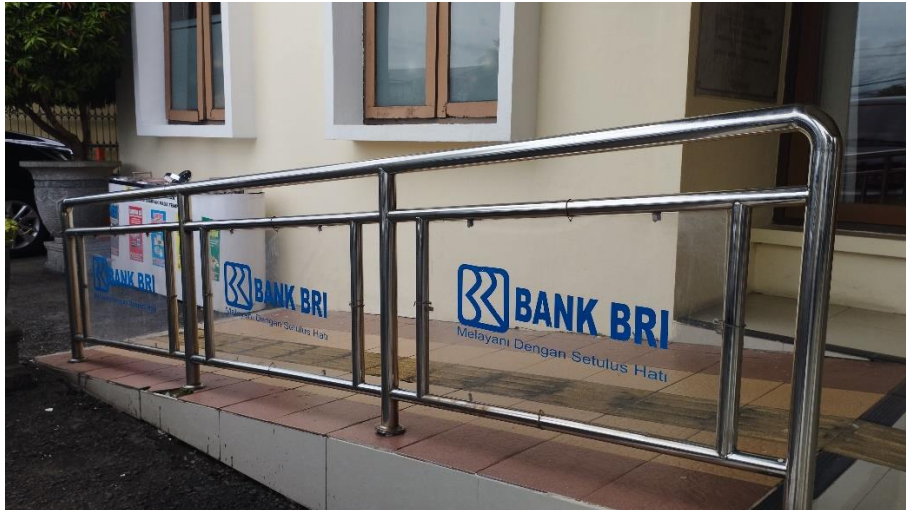
RAMP & HANDRAIL UNTUK DIFABEL KANTOR UPTPK SRAGEN
