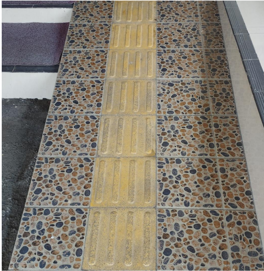
RAMP & GUIDING BLOCK UNTUK DIFABEL LOBBY KANTOR PEMKAB SRAGEN
